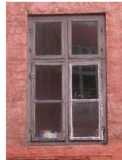
Korspost med 2 ruder i underrammen og en i overrammen (generelt på gårdsiden)
