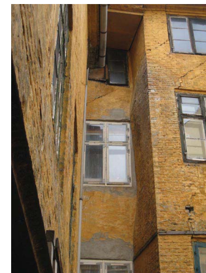
Hjørnet sætter sig 10-15 cm imellem etagernes bjælkelag
