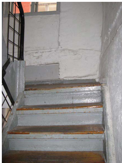
Trappen er en ½ sving trappe udført i fyrretræ
