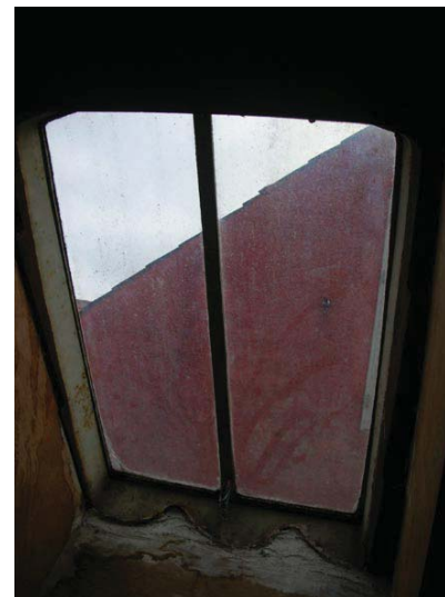
Tagvindue i byg 2. gårdside
