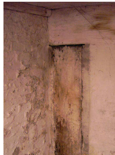
Kældervæg mellem byg 2. og forhusets gavl
