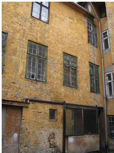
Bygning 2 - facade mod lille gård
