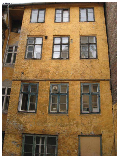
Bygning 5 - facade mod lille gård
