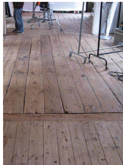
Bygning 2, 1. sal. Trægulv
