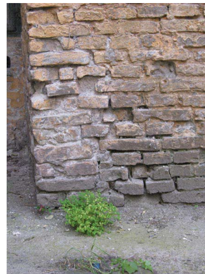
Grundfugt langs hele muren
