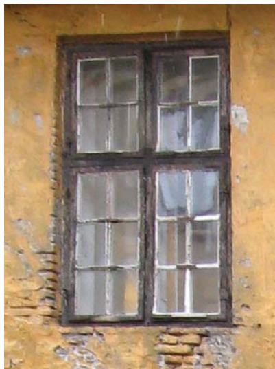
Korspost med 6 ruder i underrammen og fire i overrammen (byg. 2, lille gård, 2.sal)
