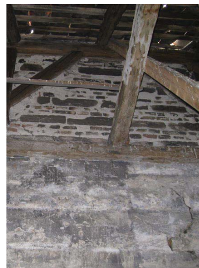
Munkesten i bagfacade
