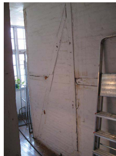
Bindingsværk fra 2.sal ved trappeopgang
