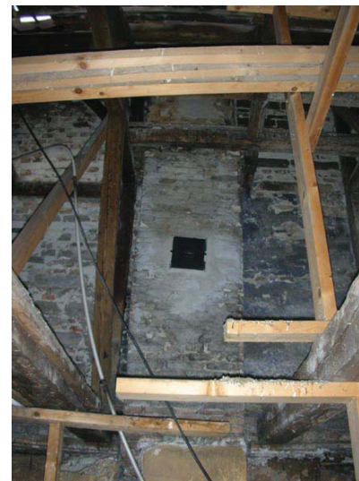
Skorsten i bagmur byg 5.
