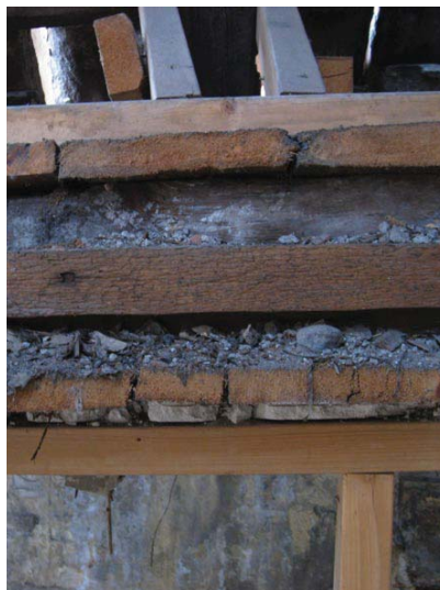
Opbygning af bjælkelag (gennemskåret bjælkelag på tagetagen)
