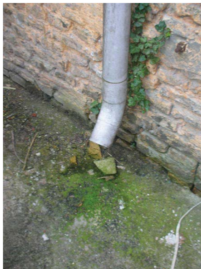
Tagnedløb uden brønd i lille gårdside byg 2.
