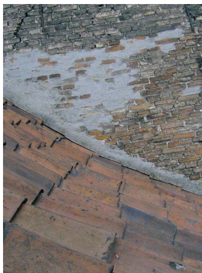
Forskelling af tagtaget på byg 2. mod forhusets gavl
