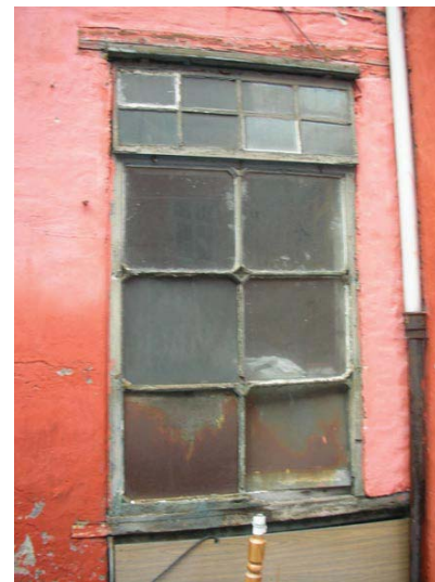
Tagnedløb gårdside byg 2.
