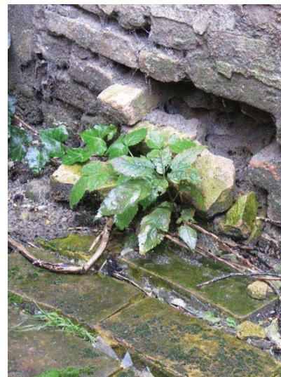
Forvitrede og udskubbede mursten. Dybe revner i fuger
