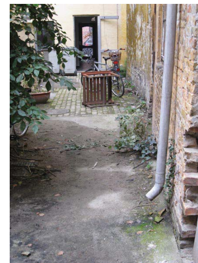
Tagnedløb fra bygning 2
