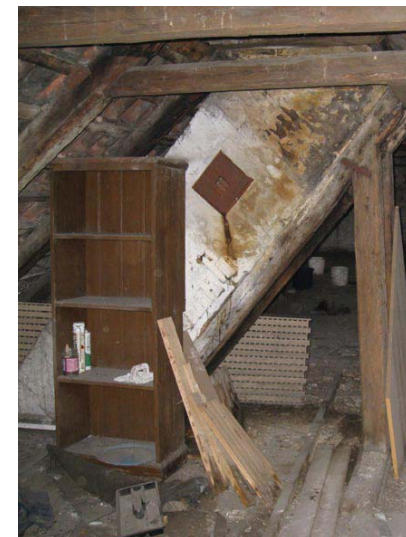
Skorsten i byg 2.
