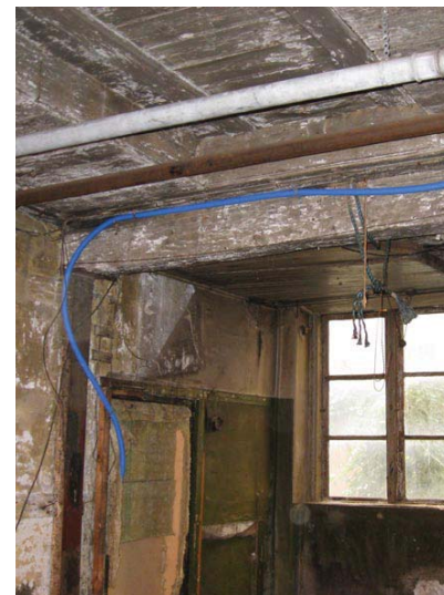
Lecene (jern) er indsat til understøtning af 9x9 tommer bjælke i værksted
