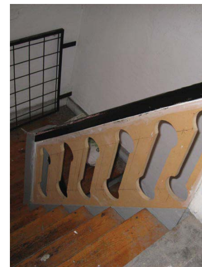
Nyt rækværk fra repos mellem 2. sal og loftet. Udskårede mdf plader, umalet
