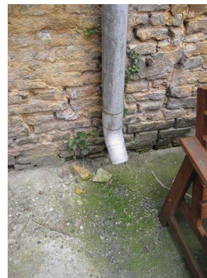
Tagnedløb fra bygning 5
