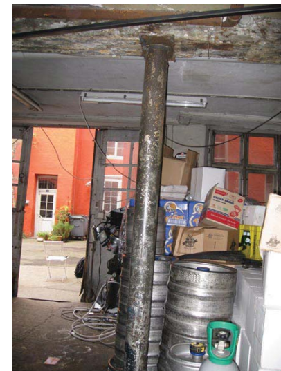
Stølsøjle indsat som understøtning af 9x9 tommer bjælke i lagerrum
