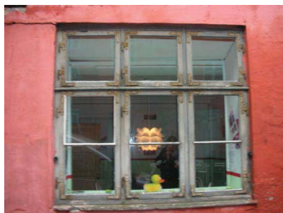
Korspost med to ruder i underrammen og en i overrammen (byg. 2, ind til fælles møderum)
